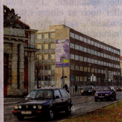
Der Block am Marstall wird für den Synagogenbau abgerissen.
