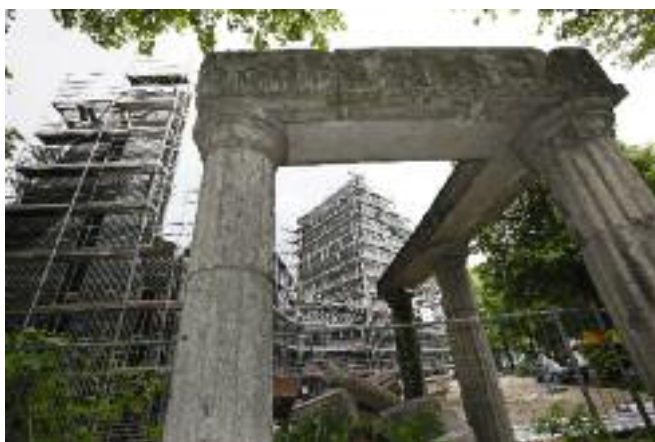
Gebäude im Entstehen © Sascha Kopp
